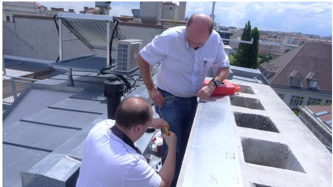
OE1DGC und OE3ILC beim Kabeleinziehen.
