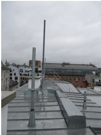
Ende Mai sind drei neue Masten am Dach.
